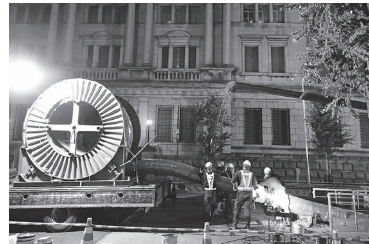
日本橋日銀通り 既設管800mmに400Aを引き込む
