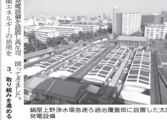
鍋屋上野浄水場急速ろ過池覆蓋部に設置した太陽光発電設備
