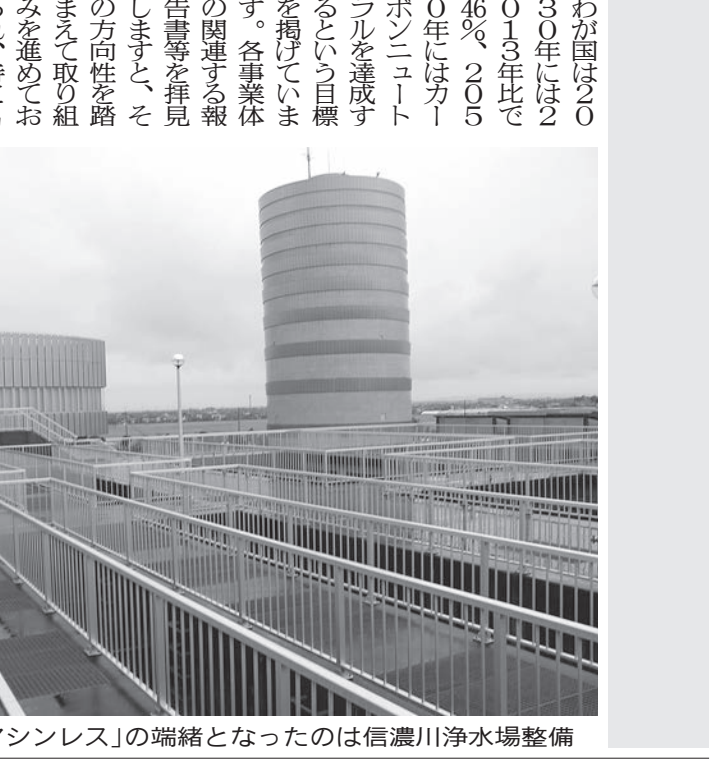
新潟市水道局の「マシンレス」の端緒となったのは信濃川浄水場整備
